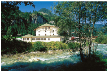
ROBINSON Club Amadé, betrieben mit Energie aus Biomasse Heizwerk.
